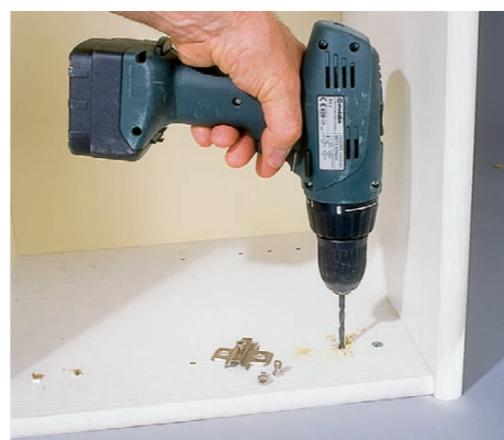
B Po wysuszeniu twardą pastę szlifujemy na gładko. Wiertłem (Ø 5 mm) wiercimy w płomkach nowe otwory na wkręty mocujące.
