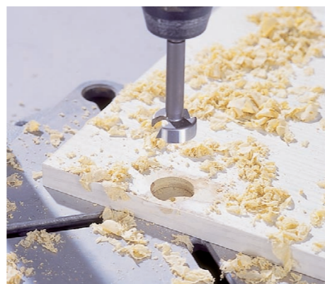
5 Wiertłem cylindrycznym (Ø 35 mm), osadzonym w wiertarce na statywie, wiercimy otwór na nowe gniazdo zawiasu garnkowego.
