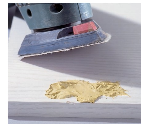
3 Nadmiar masy szpachlowej po jej stwardnieniu usuwamy ostrym dłutem, a potem szlifujemy – do zrównania z powierzchnią otaczającą otwór.
