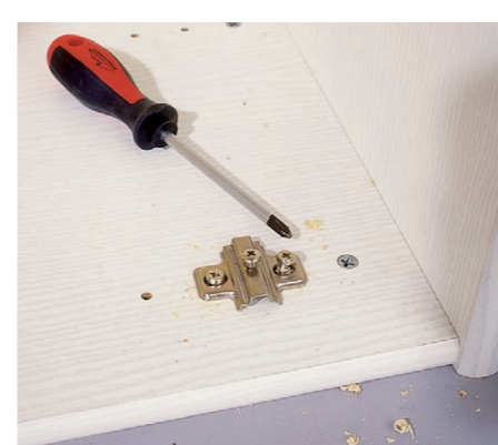
C Płytkę montażową, czyli część zawiasu połączoną z korpusem szafki, przykręcamy na poprzednim miejscu i łączymy z częścią garnkową.
