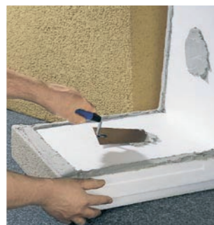
Przed ociepleniem narożników
