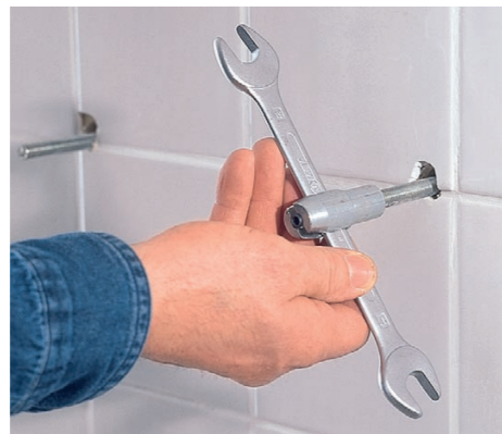
10 Koniec śruby z grubozwojowym gwintem do drewna wkręcamy w otwór kołka. Używamy specjalnego klucza.
