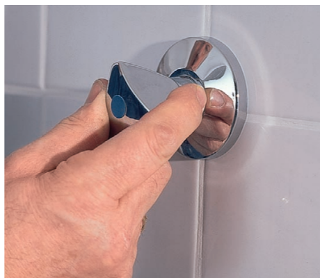
1 Zakręcamy zawory zimnej i ciepłej wody (główne). Najpierw upewniamy się, czy np. pralka lub zmywarka akurat nie pracuje.
