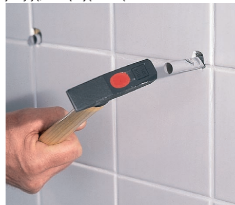
9 Z wywierconych otworów usuwamy odkurzaczem pył i wbijamy w nie młotkiem kołki rozporowe z tworzywa sztucznego.
