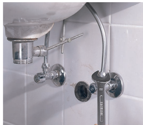
3 Po demontażu syfonu ostrożnie odkręcamy płaskim kluczem szczękowym nakrętki złączkowe na obu zaworach kątowych.
