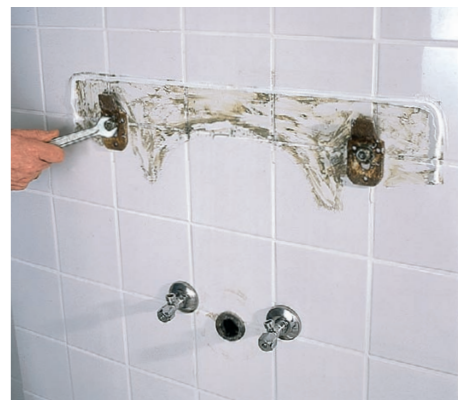
4 Usuwamy spoiny z silikonu, luzujemy nakrętki śrub, odrywamy umywalkę od ściany, zdejmujemy ją, odkręcając nakrętki.
