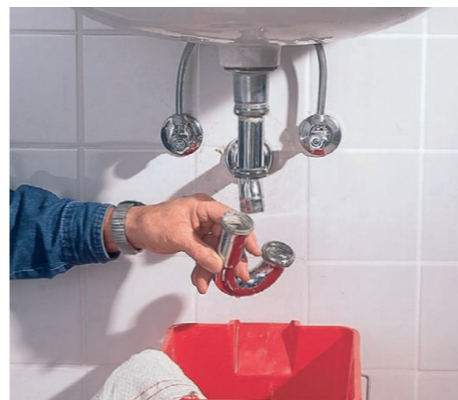
2 Pod umywalkę podstawiamy wiadro, następnie kluczem do rur odkręcamy obie nakrętki syfonu i całkowicie go odłączamy.
