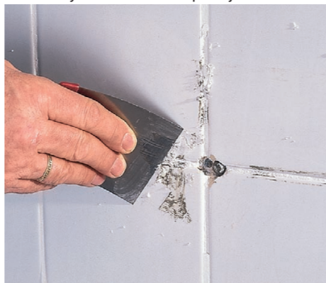
6 Ostrą stalową szpachelką usuwamy z glazurowanej powierzchni ściany resztki silikonowych spoin i wszelkie inne zanieczyszczenia.
