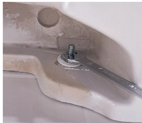
14 Teraz przyda się pomocnik, by przytrzymać umywalkę osadzoną luźno na śrubach w czasie dokręcania nakrętek.
