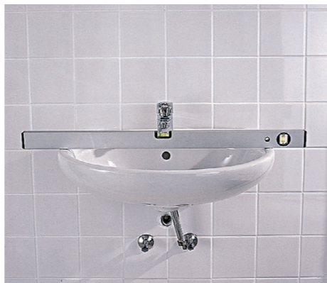
15 Przed dociśnięciem nakrętkami dużych plastikowych podkładek sprawdzamy poziomiczką położenie umywalki na ścianie.
