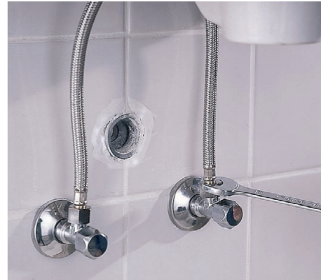
16 Nowe, giętkie, samuszczelniające się rurki zakładamy na zawory kątowe i dokręcamy ich końcówki kluczem szczękowym.
