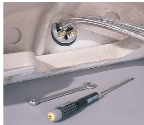
13 Dalszy montaż i podłączenie urządzenia do instalacji ułatwia wcześniejsze zamontowanie nowej armatury do umywalki.
