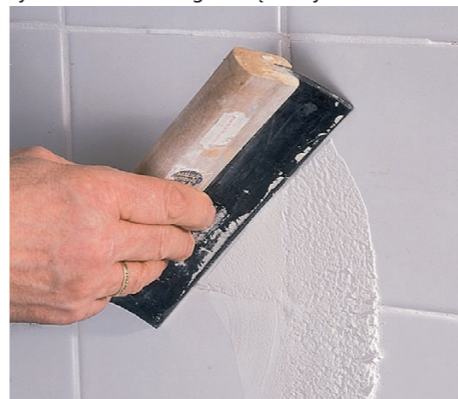
7 Masą szpachlową do glazury wypełniamy wszystkie otwory i szczeliny. Potem wycieramy całą powierzchnię ściany wilgotną gąbką.
