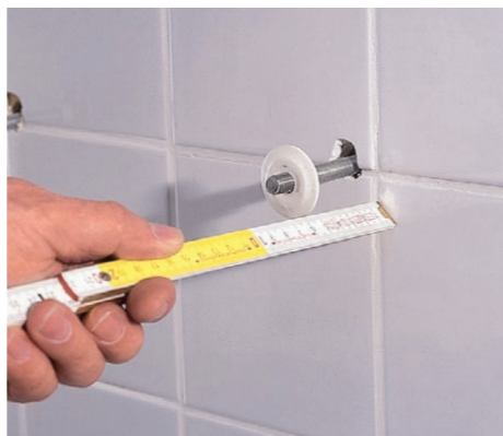
11 Śruby mocujące wkręcamy w ścianę tak, by wystawały z niej na grubość tylnej ścianki umywalki i dwóch standardowych nakrętek.
