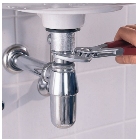
17 Skręcamy ze sobą elementy nowego syfonu i wsuwamy odpływ do otworu w ścianie. Potem mocujemy syfon do umywalki.
