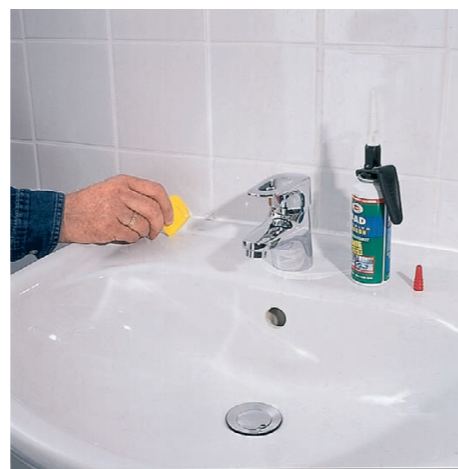
19 Po sprawdzeniu szczelności połączeń (przez odkręcenie wody i obserwację) możemy uszczelnić umywalkę silikonem.
