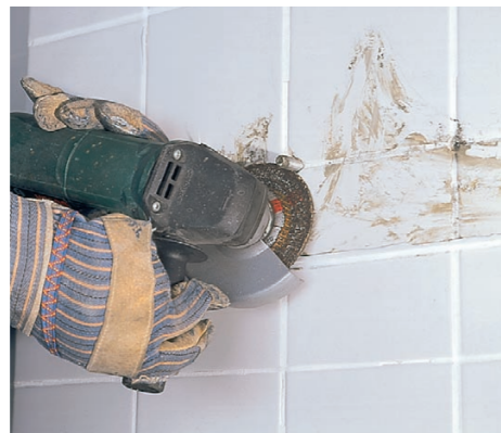
5 Stare śruby wykręcamy lub odcinamy szlifierką kątową z tarczą do cięcia metalu. Koniecznie z użyciem okularów ochronnych!
