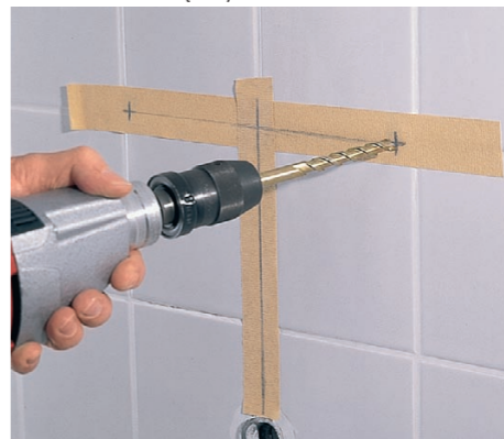
8 Mierzmy rozstaw otworów umywalki i zaznaczamy ich miejsca na ścianie. Używamy wiertła do betonu i wiertarki bez udaru.
