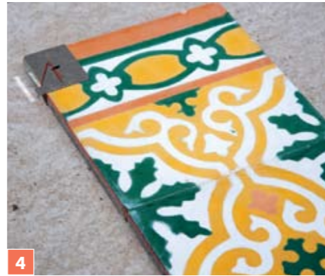
Klej nakładamy za pomocą szpachelki zębatej i układamy płytki, tworząc spoiny szerokości 1–1,5 mm.
