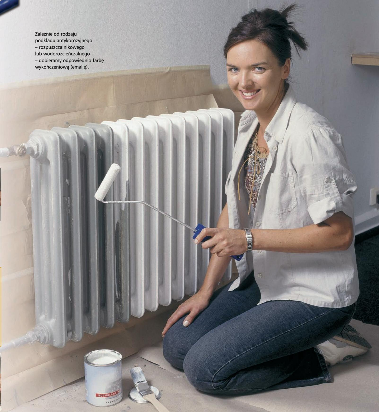
Pod wpływem dużych zmian temperatury wody grzejnik rozpręża się i kurczy, co może powodować powstawanie nieestetycznych rys na pomalowanej powierzchni i żółknięcie farby. Dobra po-
