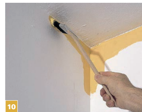
10 Za pomocą pędzla do malowania grzejników malujemy styki ścian i sufitu. Pędzla nie należy zanurzać w farbie zbyt głęboko.
