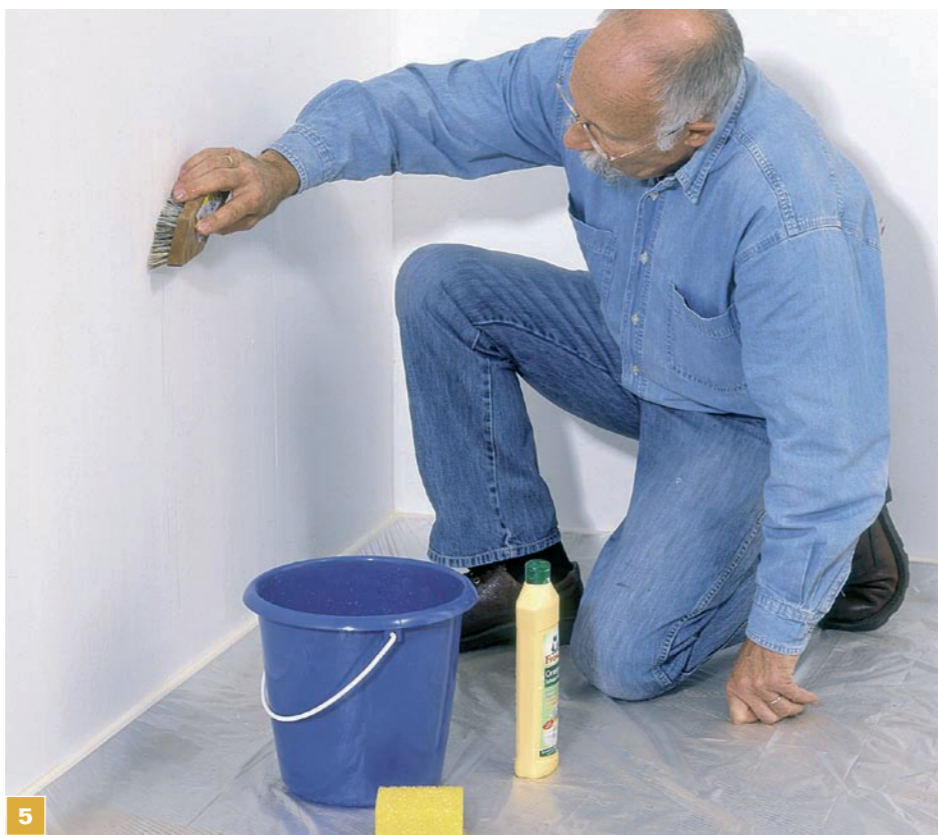
5 Zabrudzone ściany trzeba dokładnie oczyścić z kurzu i tłustych plam. Można to zrobić za pomocą gąbki lub szczotki, np. rozcieńczonym ciepłą wodą środkiem czyszczącym.
