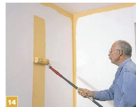
14 Wałek nasączony farbą prowadzimy od dołu ku górze. Dzięki temu farba nie kapie na podłogę.
