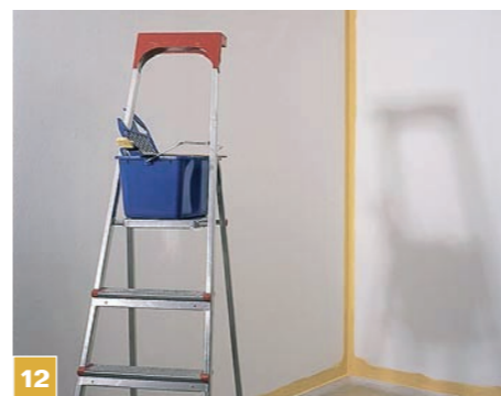
12 Pędzlem malujemy również ściany przy podłodze.
