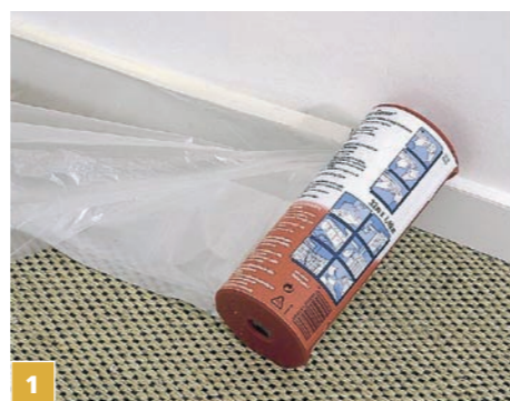
1 Na całej podłodze rozkładamy folię malarską, którą przyklejamy taśmą przy ścianach.
