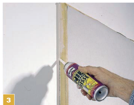
3 Ościeżnice drzwi również oklejamy taśmą malarską. Duże szpary między nimi i ścianami wypełniamy masą akrylową wyciskaną z kartuszy.
