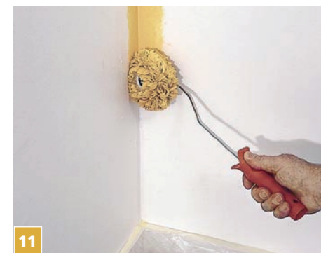
11 Do malowania narożników wewnętrznych (kątów) używamy wałka w kształcie stożkowatego wałka, przeznaczonego do kątów prostych.
