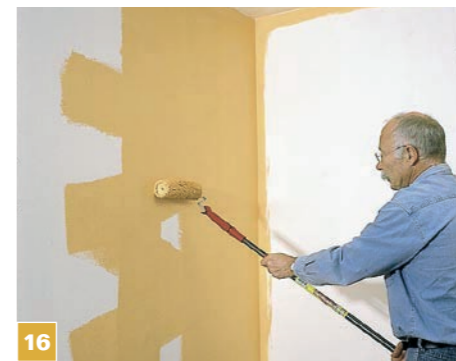
16 Po rozprowadzeniu farby wzdłuż i w szerz malujemy ścianę pionowymi ruchami wałka.
