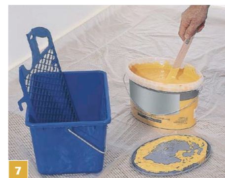
7 Zanim zaczniemy nakładać nowo otwartą farbę, powinniśmy ją dobrze wymieszać, ponieważ ciężkie pigmenty często osiadają na dnie.
