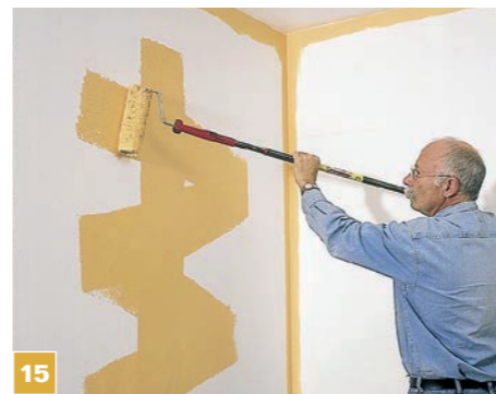
15 Gdy farba jest nałożona zbyt grubo, rozprowadzamy ją w poprzek ściany (poziomo), a następnie natychmiast wykonujemy pociągnięcie pionowo (póki farba jest mokra).
