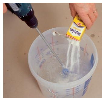
1 Najpierw mieszamy klej dosypując stopniowo proszek do wody wprawianej w ruch mieszadłem. Zawiesinę pozostawiamy do napęcznienia.
