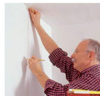
9 Przed przyklejeniem pierwszego pasma do ściany musimy na niej wyznaczyć według pionu lub poziomnicy dwie linie krawędziowe.
