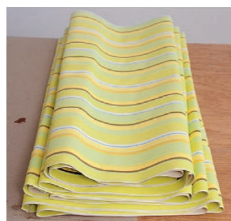
8 Przygotowujemy zapas 3-4 pasm. Układamy je jedno na drugim i pozostawiamy do zmięknienia, by stały się bardziej elastyczne.
