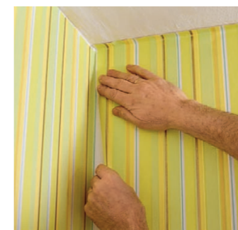
16 Ostatnie pasmo przyklejamy w kącie równo z linią styku ścian. Jego brzeg powinien zakryć odgięty, wąski pasek sąsiedniego pasma.
